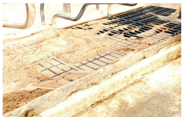
Abziehen, festtreten, überfüllen - fertig
